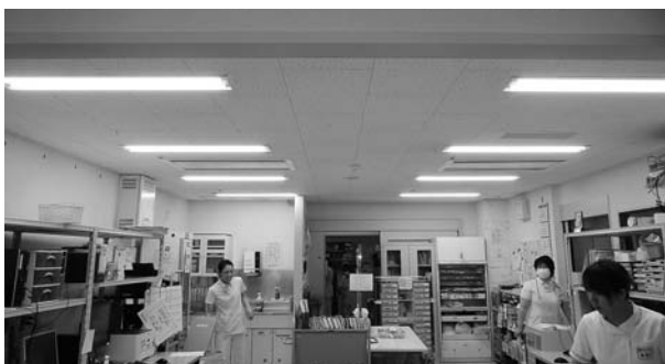
ナースステーションLED照明へ変更
