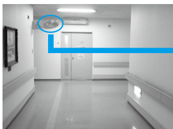
衝突防止ミラーの設置：1階廊下
