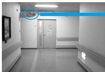
衝突防止ミラーの設置：1 階廊下
